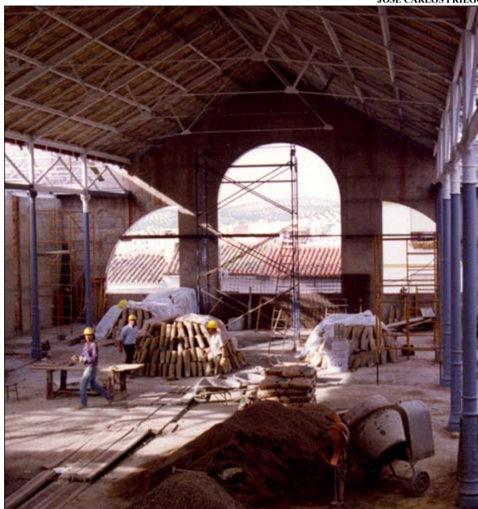
Obras de construcción del Teatro Liceo.
